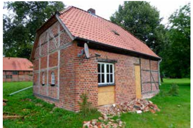
Renovierungsarbeiten am Backhaus im Gudower Pfarrhofensemble
